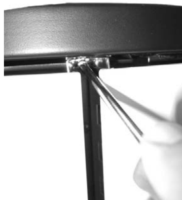
Fig. 40 - Βιδώστε το στήριγμα
