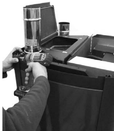
Fig. 91 - Αφαίρεση καμπύλων επάνω προφίλ
