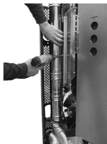
Fig. 64 - Στερέωση σωλήνα
