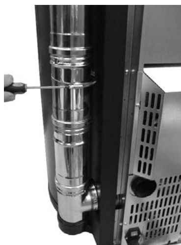
Fig. 103 - Αγωγός καπνού (Sfera³ Plus, Sfera³, Globe, Elise³ Plus)
